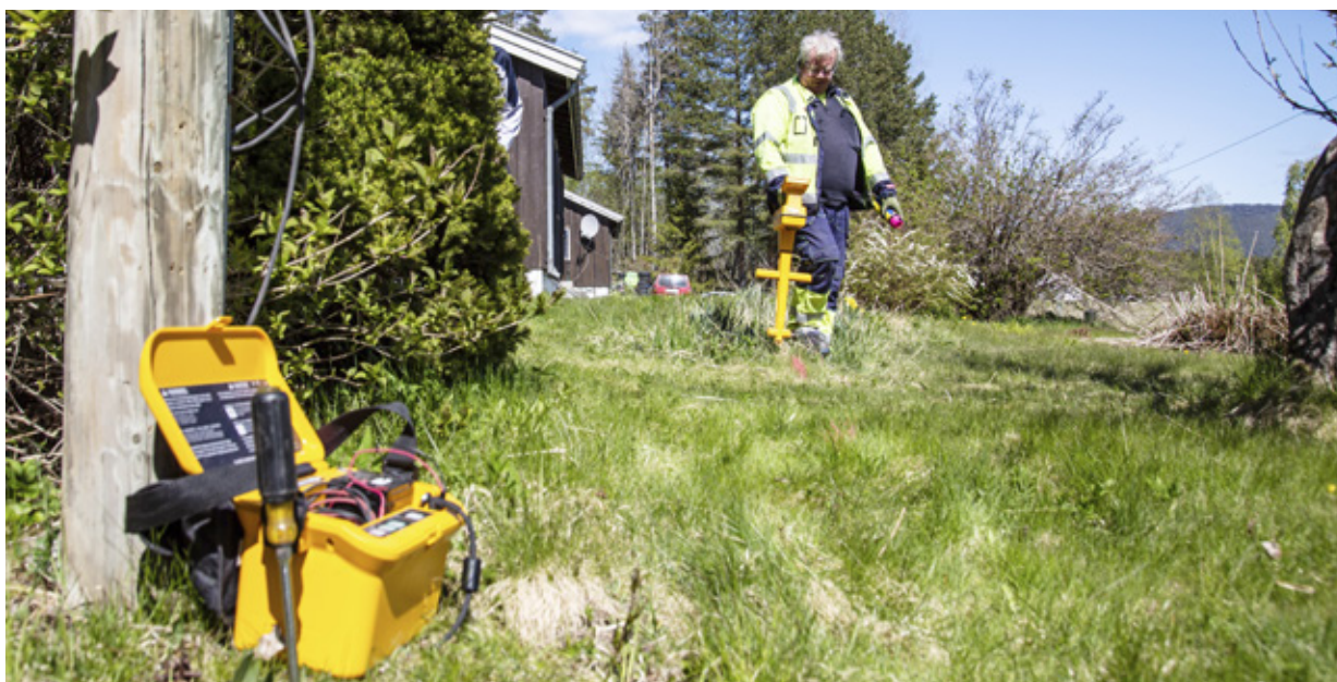
Svein Ivar Gislegård peiler før graving av fiber inn til bolig i Sigdal, foto: Trond Lindseth
