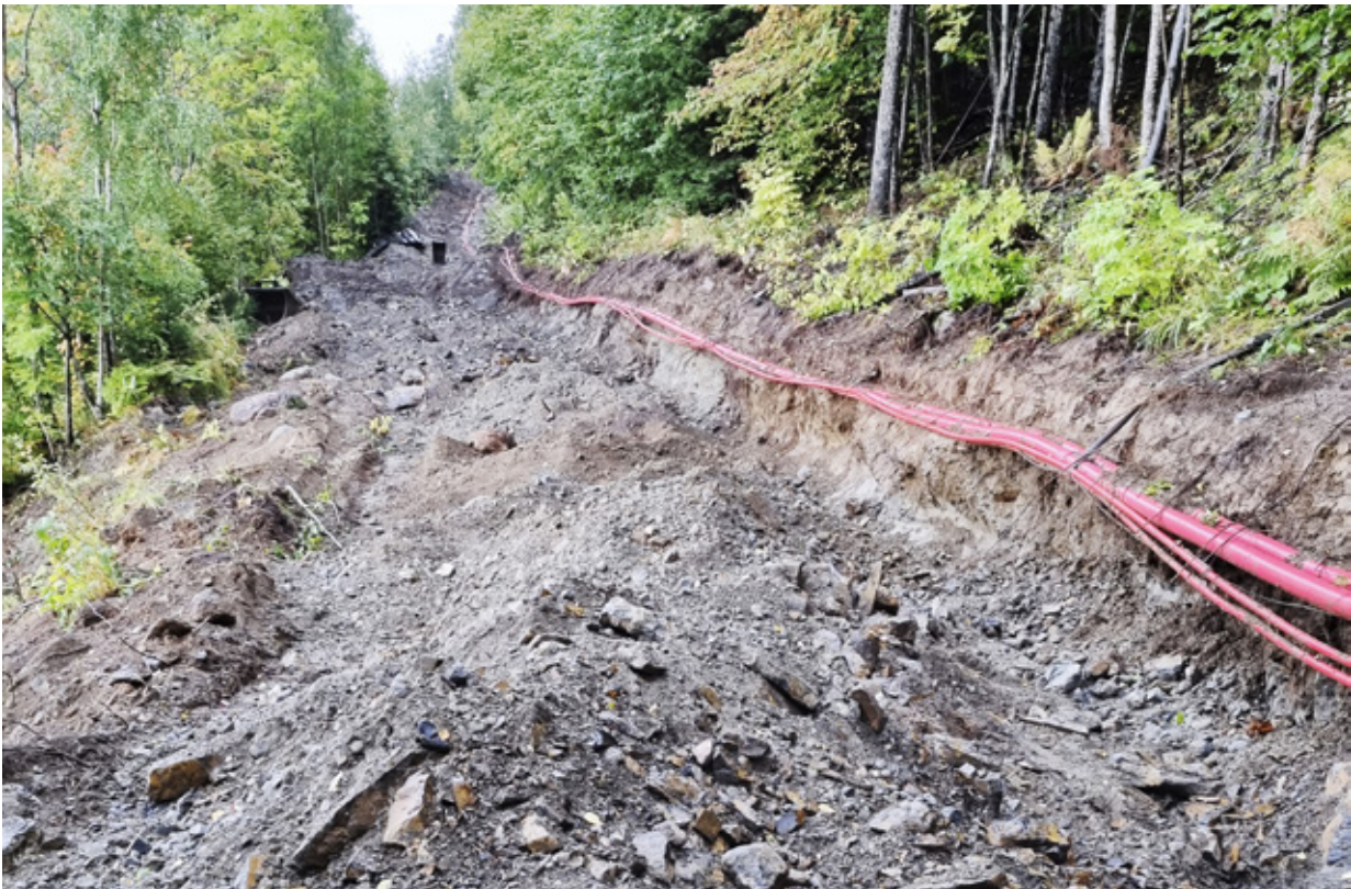
Rehabilitering av kabelgrøft Pilterud.
