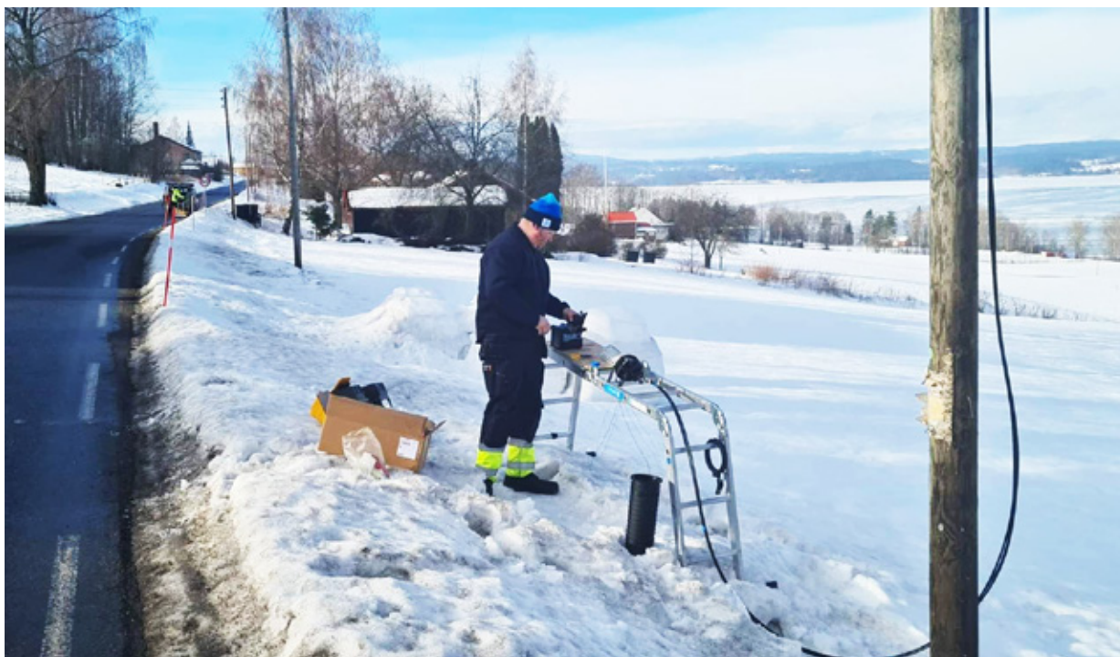
Skjøting av fiber på Øst-modum, foto: Stian Engen
