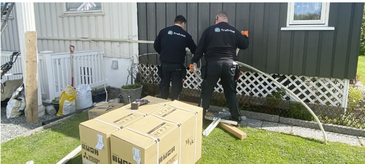
Tommy og Ole Kristian på varmepumpe montering i Hønefoss, foto: Trond Lindseth
