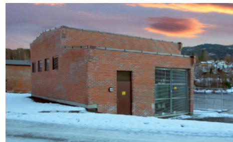
Kongsfoss kraftstasjon ved Åmot
