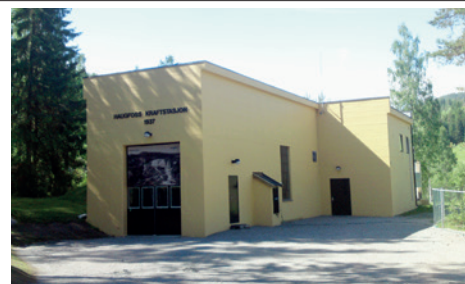
Haugfoss kraftstasjon ved Blaafarveværket
