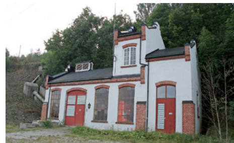
Dyrbak kraftstasjon på Østmodum
