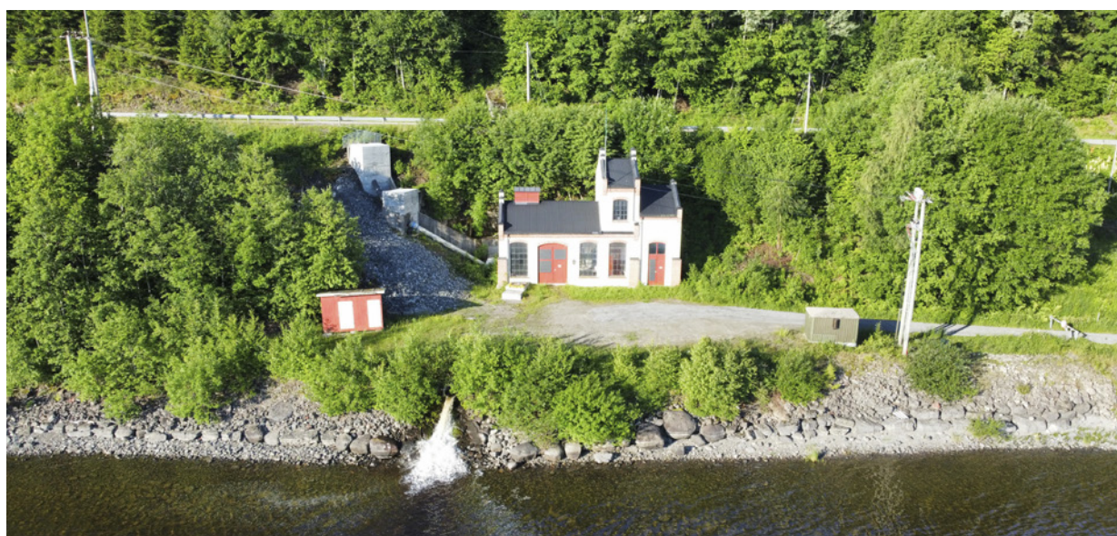
Dyrbak kraftverk, foto: Trond Lindseth
