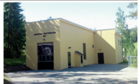
Haugfoss kraftstasjon ved Blaafarveværket
