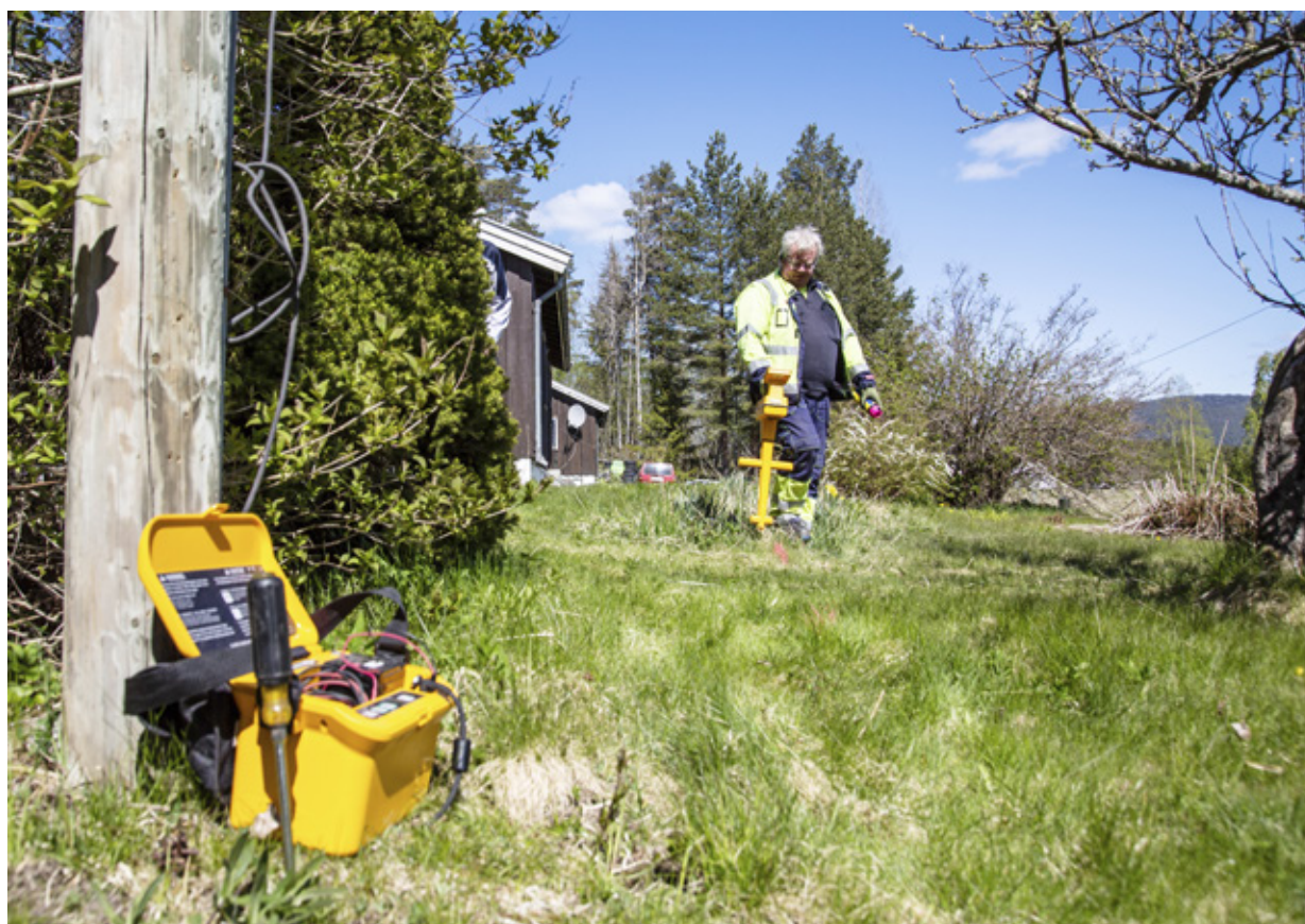
Svein Ivar Gislegård peiler før graving av fiber inn til bolig i Sigdal, foto: Trond Lindseth
