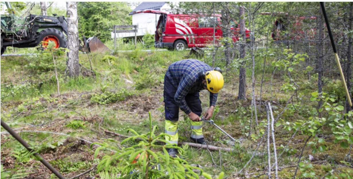
Bjørn Hoffart klargjør nye solide bardunfester ved utskifting av gammel stolpe, foto: Trond Lindseth
