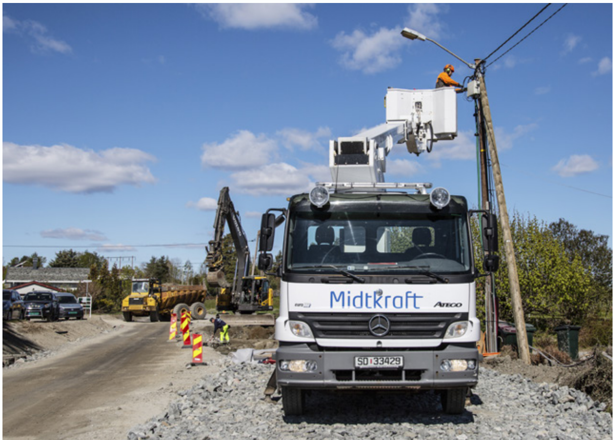
Stor ombygging av lavspentnettet ved Badeveien, i kurvbilen Truls Eivind Skretteberg, foto: Trond Lindseth
