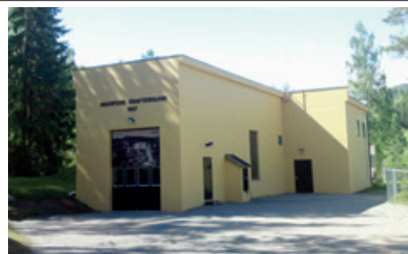
Haugfoss kraftstasjon ved Blaafarveværket
