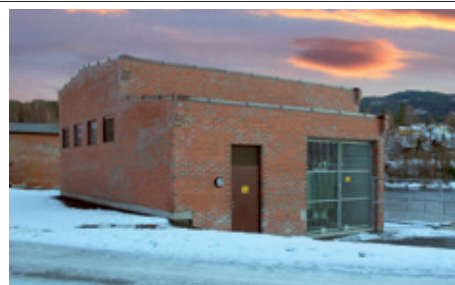
Kongsfoss kraftstasjon ved Åmot
