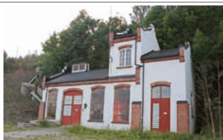
Dyrbak kraftstasjon på Østmodum
