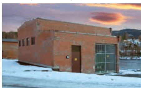
Kongsfoss kraftstasjon ved Åmot
