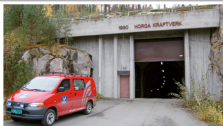
Inngangspartiet til Horga kraftstasjon ved Soneren i Sigdal
