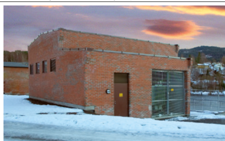
Kongsfoss kraftstasjon ved Åmot
