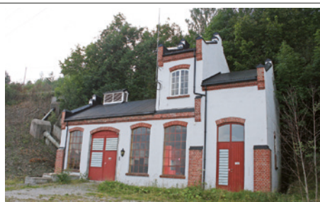
Dyrbak kraftstasjon på Østmodum
