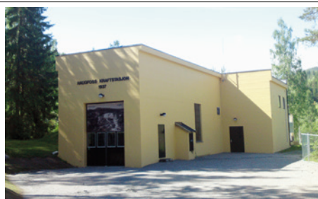
Haugfoss kraftstasjon ved Blaafarveværket
