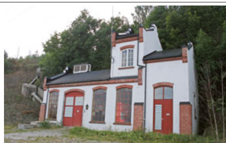
Dyrbak kraftstasjon på Østmodum
