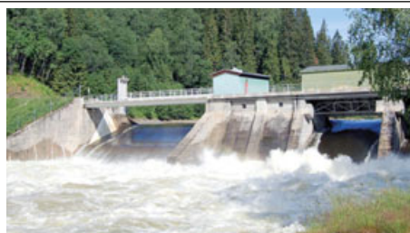
Inntaksdammen i Ramfoss – som ligger like ved Kløfdefoss
