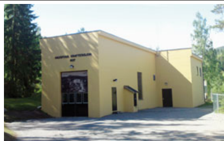
Haugfoss kraftstasjon ved Blaafarveværket
