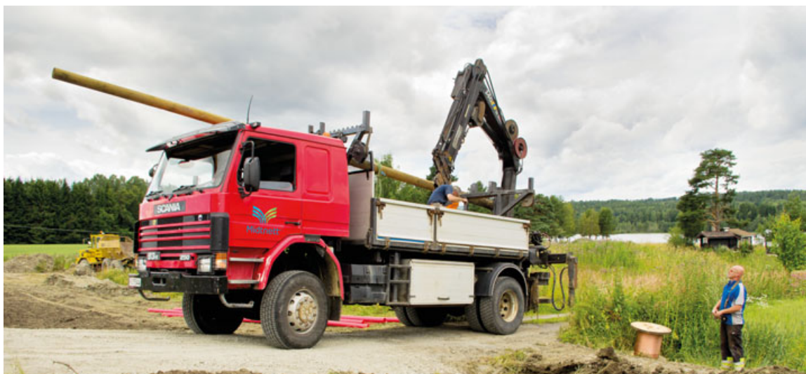
Rehabilitering av linje på Øst-Modum, foto Erik Thalerud.
