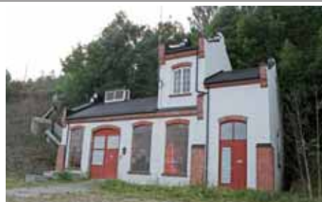
Dyrbak kraftstasjon på Østmodum
