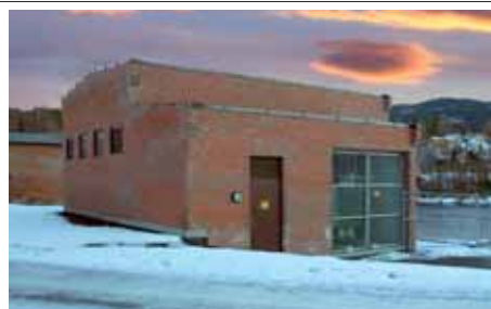
Kongsfoss kraftstasjon ved Åmot
