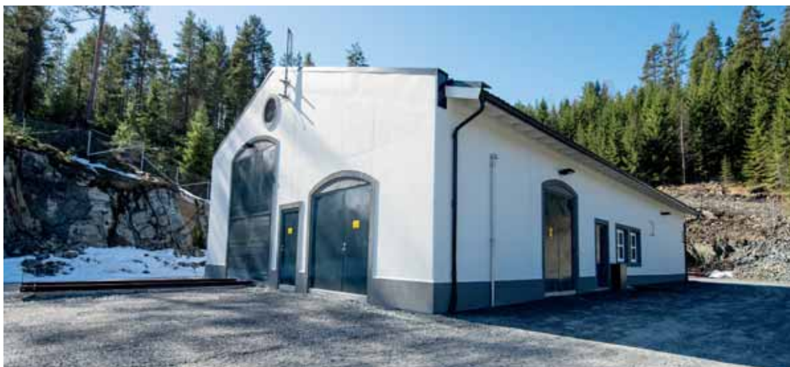
Nye Sundbakken trafostasjon, foto Erik Thalerud.
