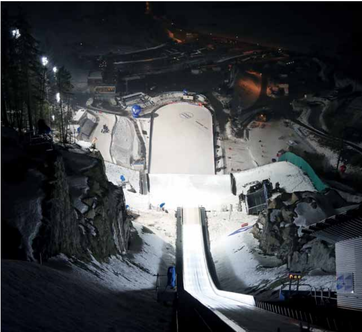
Strøm til dette flotte lysanlegget kommer fra den lokale strømleverandøren, Midtkraft. Foto Trond Lindseth.
