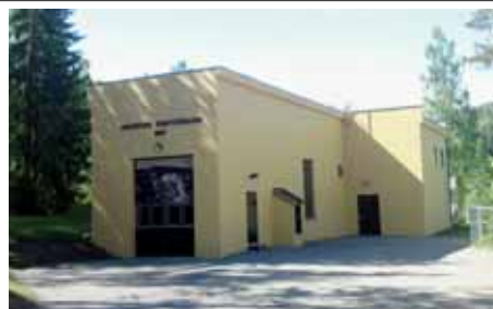
Haugfoss kraftstasjon ved Blaafarveværket
