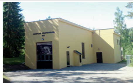
Haugfoss kraftstasjon ved Blaafarveværket
