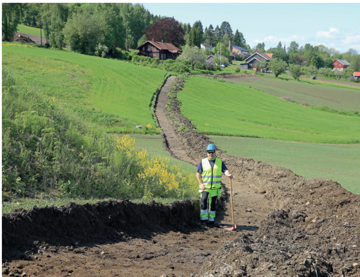
Arkeolog følger utgraving av kabelgrøft på Øst-Modum.. Foto: Trond Lindseth
