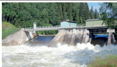
Inntaksdammen i Ramfoss – som ligger like ved Kløftefoss
