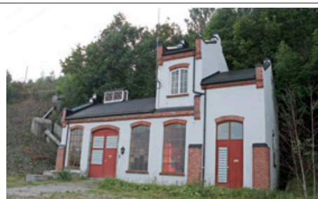
Dyrbak kraftstasjon på Østmodum
